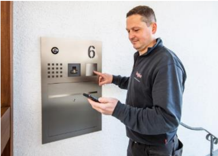
((siedle_modernisierung_tuerkommunikation_smart_gateway_41002)) Mobiler Klingel-Test: Elektroniker Miroslaw Koziol prüft den Türruf, der über die Siedle App auf dem Smartphone ankommt.
